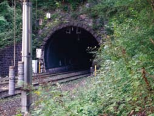
Hier beim Berg-Isel-Tunnel (662 m lang) erfolgte am 23. Februar 1864 der erste Spatenstich; Foto: Gerd Schröter
